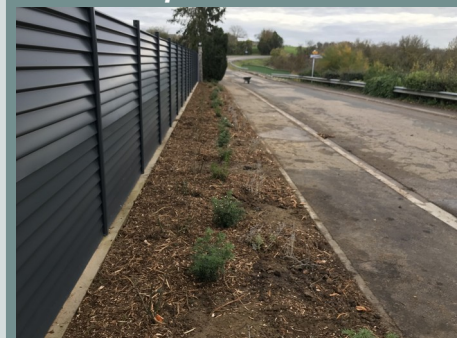
... Le parterre terminé
